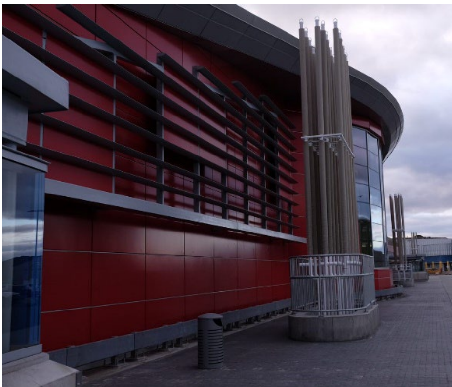
L'aéroport d'Iqaluit a été construit avec un système de « thermosiphons » pour évacuer la chaleur avant qu'elle n'atteigne le pergélisol en dessous.
