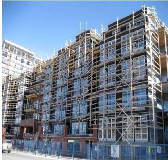
Figure 4 – Édifice Ellis de Kelowna en Colombie-Britannique lors de sa construction – Le premier édifice de six étages à ossature de bois en Colombie-Britannique 47
