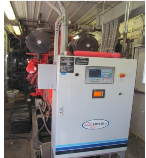
Photo : Cour générateur qui fonctionne au biogaz. Photo prise lors d'une visite du comité à la ferme de M. Jacques Laforge, à Saint-André, au Nouveau-Brunswick, en novembre 2012.
