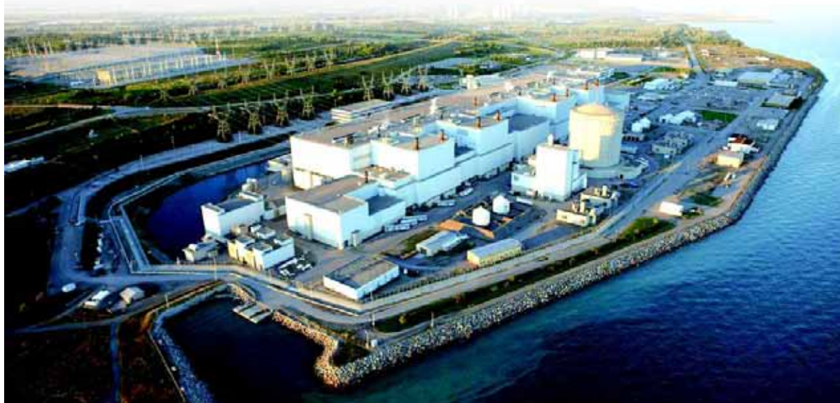
Centrale nucléaire de Darlington, Ontario Power Generation
